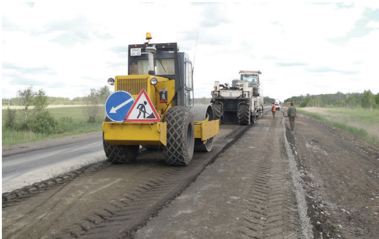
Рис. 1. Устройство основания из стабилизированного грунта
