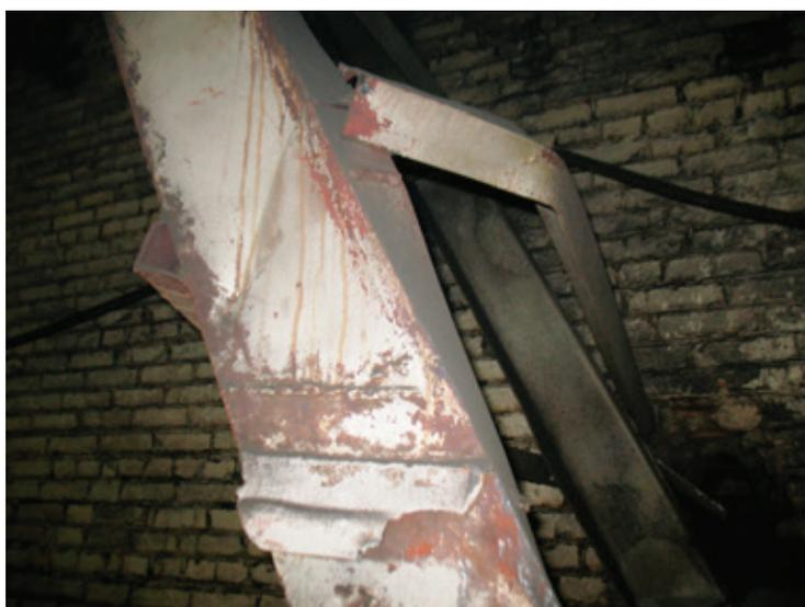
Рис. 5. Повреждение вертикальной связи
