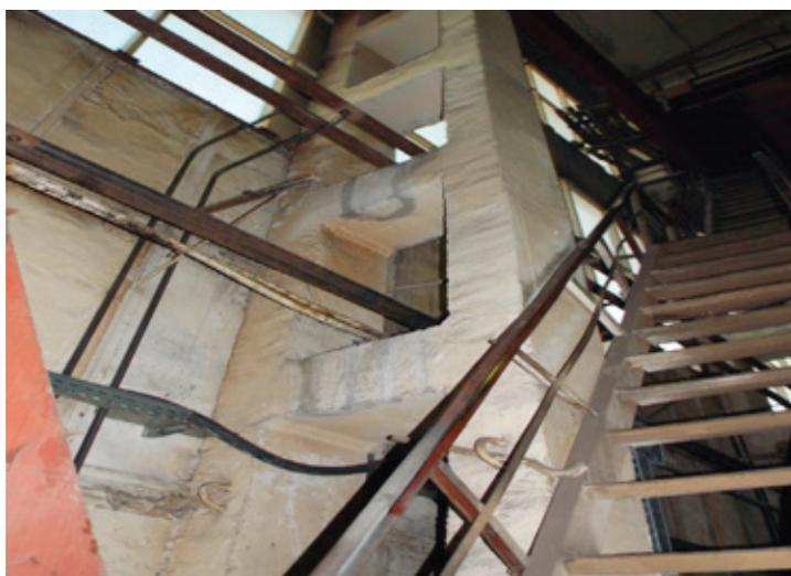
Рис. 3. Замачивание поверхности колонны
