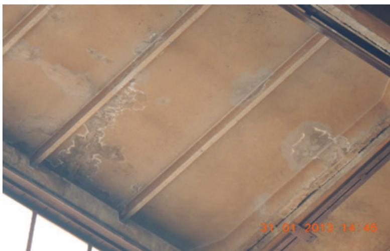
Рис. 6. Замачивание поверхности ребристой плиты покрытия
