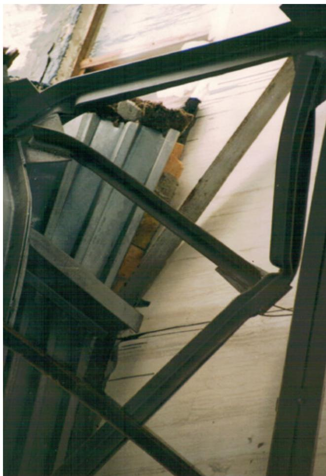
Рис. 1. Ферма после обрушения ОАО «Пензхиммаш»
