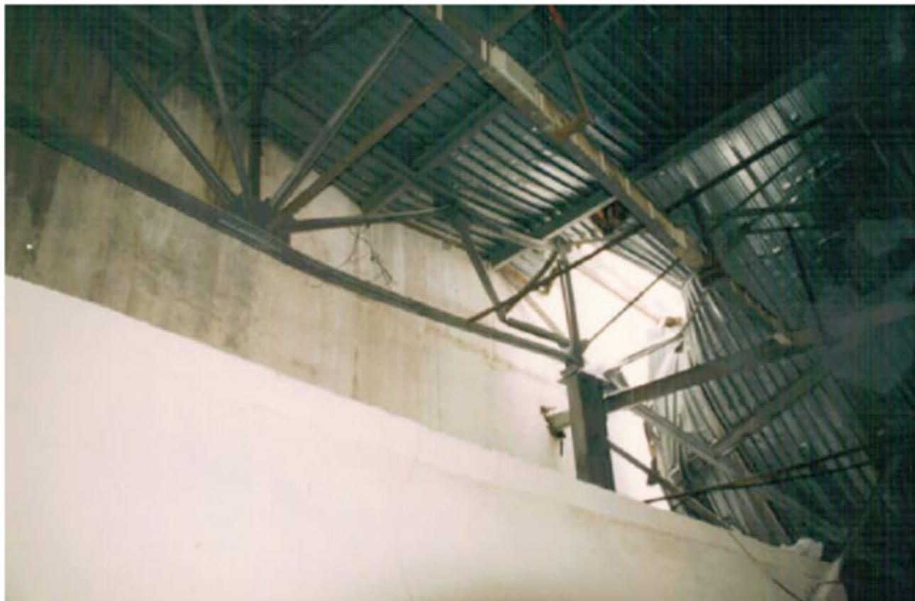
Рис. 2. Обрушение пролета ОАО «Пензхиммаш»
