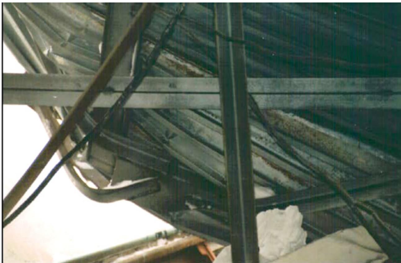
Рис. 3. Характерные повреждения металлических конструкций после обрушения
