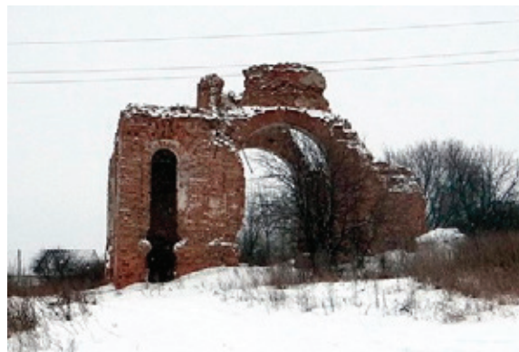
Рис. 2. Храм, сохранивший элементы несущих конструкций (Воскресенский храм с. Воскресеновка, Пензенского района)
