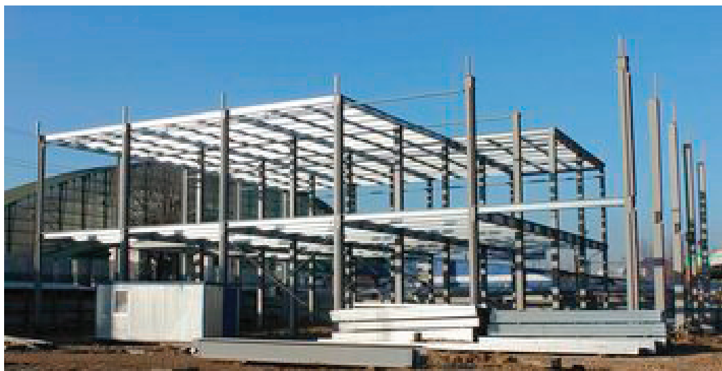
Рис. 1. Metalloкаркас быстровозводимого здания
