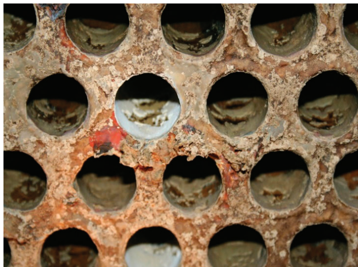
Рис. 2. Конденсаторные трубки входной камеры с кальциево-карбонатными отложениями
