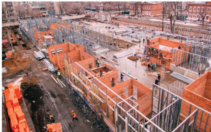
Рис. 2. Возведение каркасно-панельного здания (фотография из статьи [5–6]) со встройками из кирпичных перегородок при строительстве «Многофункционального медицинского центра» в г. Уссурийске на 60 мест.
