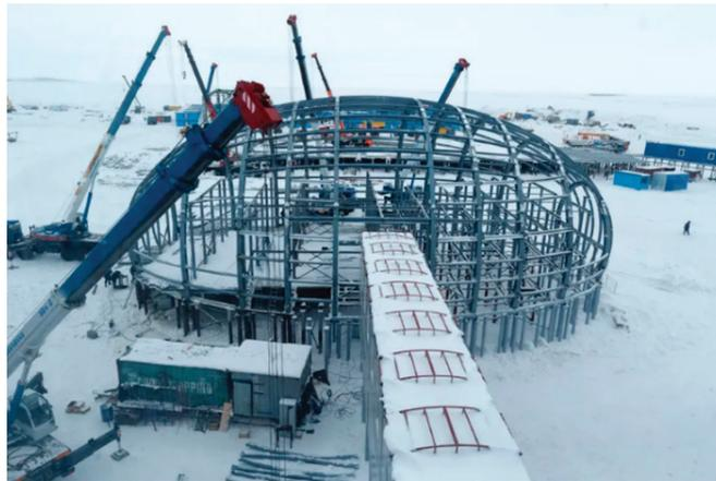
Рис. 1. Возведение каркаса из оцинкованных холодногнутых профилей одного из зданий комплекса «Арктический Трилистник» [1]
