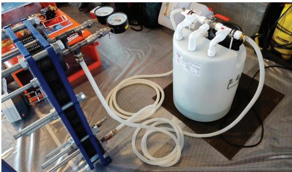
Рис. 5. Промывка оборудования активными реагентами
