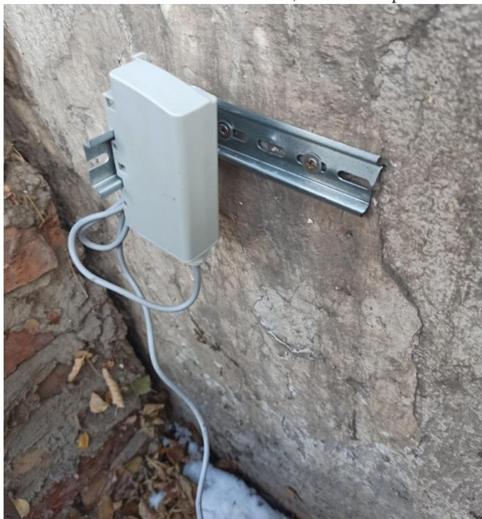
Рис. 6. Установка радиомодема
