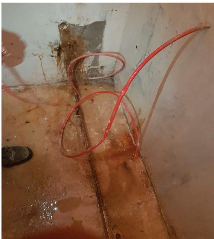
Рис. 2. Выявленные активные течи на объекте по сопряжению фундаментной плиты со стеной, а также на дефектных участках бетона
