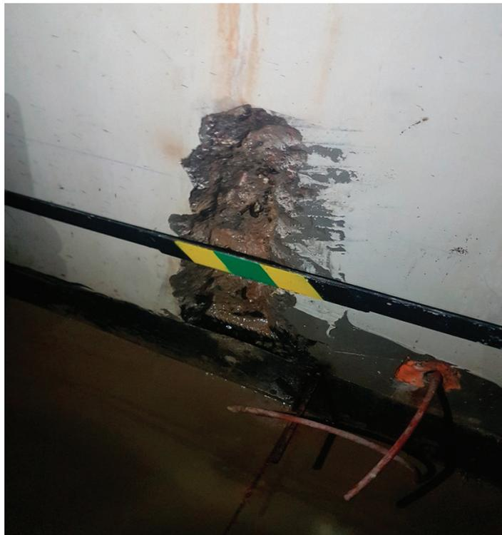
Рис. 3. Наличие активных течей через имеющиеся дефекты бетона
