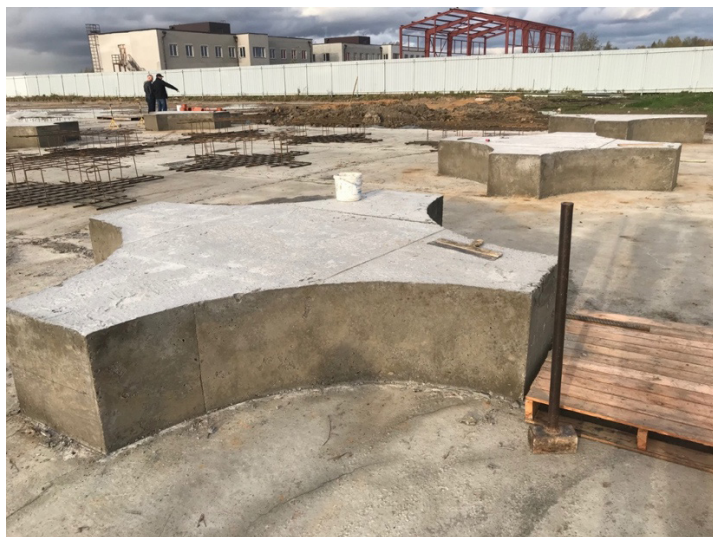
Рис. 5. Конструкция фундамента под колонну
