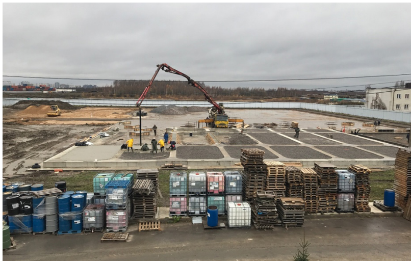
Рис. 1. Поверхностные фундаменты
