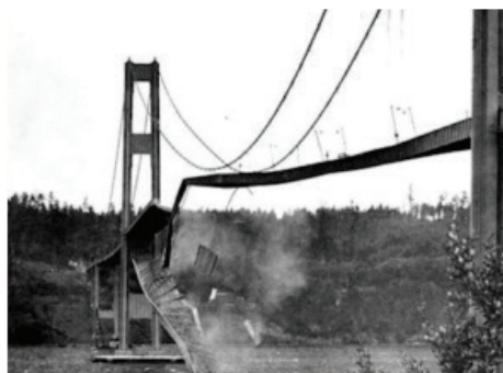
Рис. 1. Крушение моста Тэкома — Нэрроуз, 7 ноября 1940 год [1]
