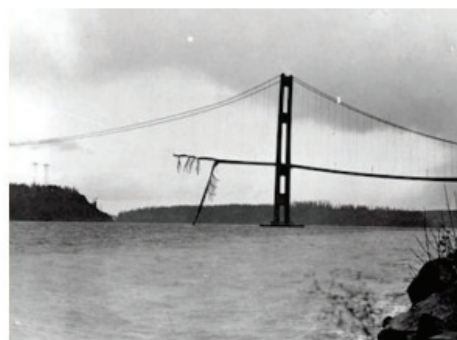
Рис. 1. Крушение моста Тэкома — Нэрроуз, 7 ноября 1940 год [1]
