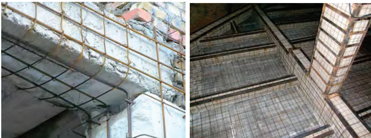
Рис. 2. Внешнее металлическое армирование восстанавливаемого промышленного здания
