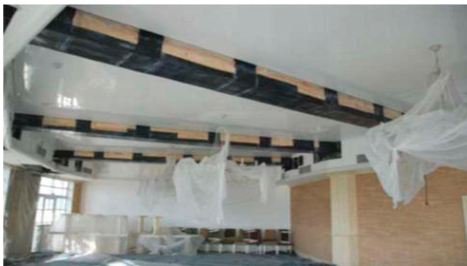
Рис. 2. Усиление деревянных балок композитами
