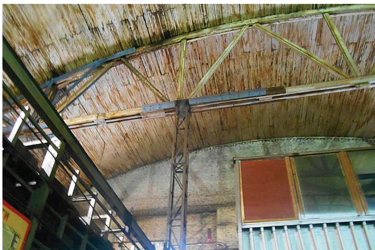
Рис. 2. Усиление фермы промежуточными стойками
