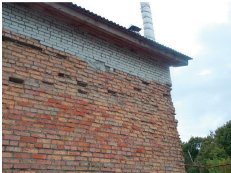
Рис. 3. Разрушение кладки стен
