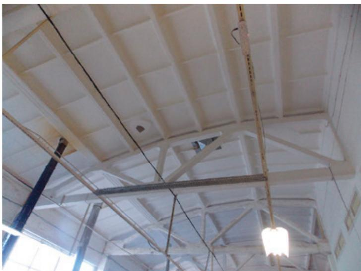
Рис. 3. Общий вид железобетонных ферм
