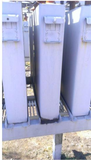
Рис. 2. Разгерметизация корпуса БСК при перегрузке (нижняя часть бака)
