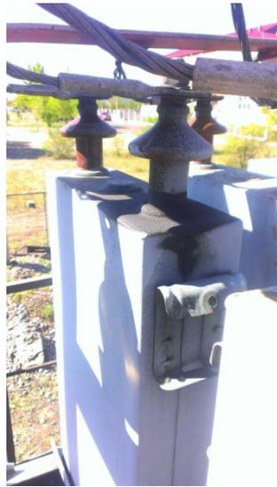
Рис. 1. Разгерметизация корпуса БСК при перегрузке (верхняя часть бака)
