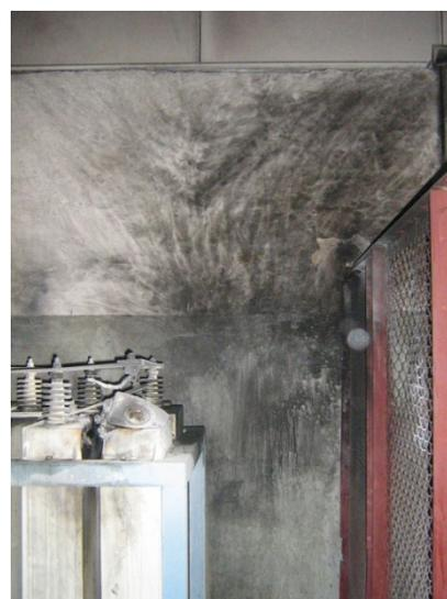
Рис. 3. Разгерметизация корпуса БСК при коротком замыкании
