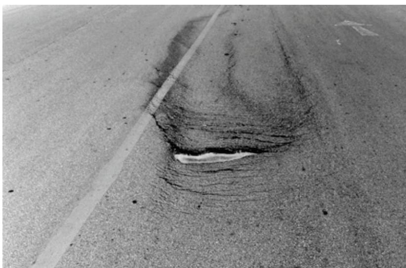
Рис. 3. Поверхностная колея на покрытии, сопровождаемая просадкой асфальтобетона и сеткой трещин
