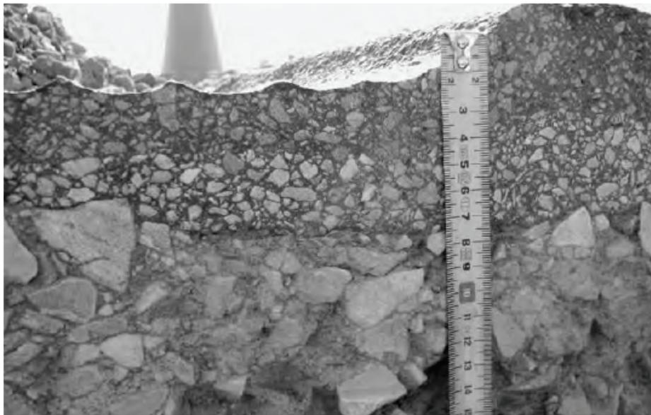
Рис. 4. Измерение глубины поверхностной колеи в верхнем и нижнем слое покрытия, сопровождаемой выпором асфальтобетона [2]
