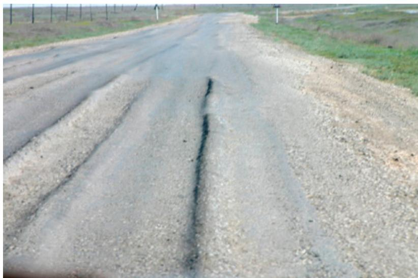
Рис. 2. Поверхностная колея на покрытии, сопровождаемая боковым выпором асфальтобетона
