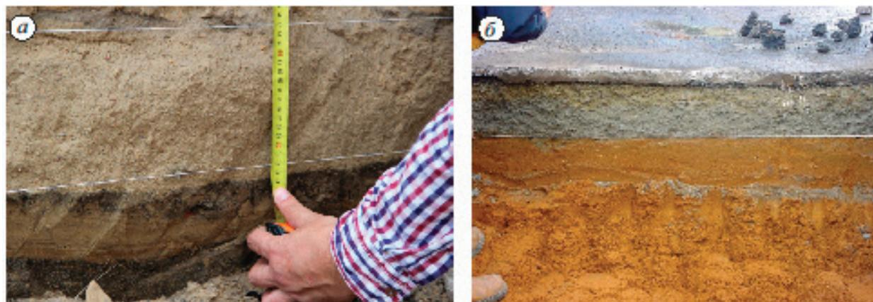
**Рис. 1. Иллюстрация пластического деформирования слоев оснований дорожной одежды: а — копирование песчаным слоем пластического смещения поверхности земляного полотна [7]; б — копирование деформации щебеночного основания асфальтобетонным тонкослойным покрытием [8]**
