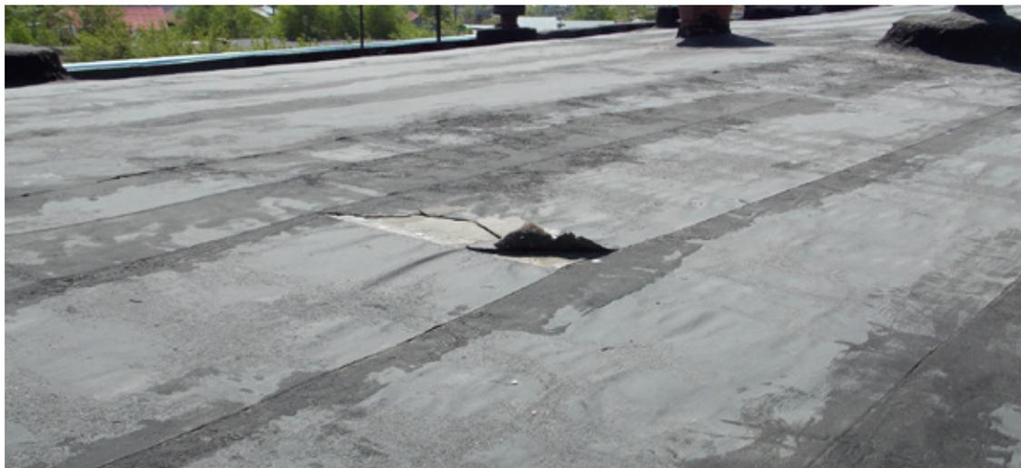
Рис. 4. Нарушена целостность кровельного покрытия (Категория Б)
