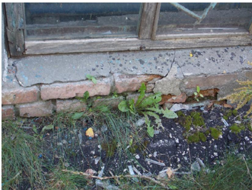
Рис. 1. Трещины в цокольной части, наличие сорных трав в районе отмостки (Кат Б.)
