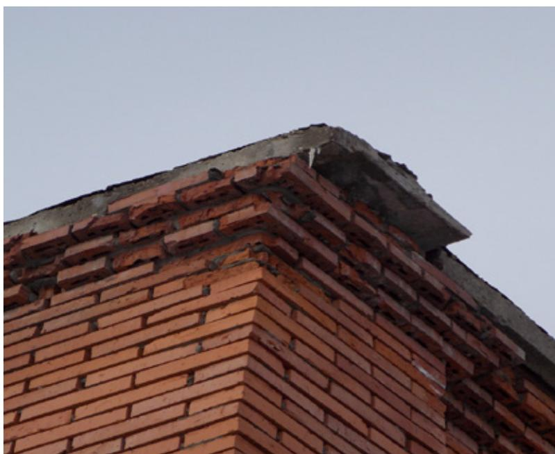
Рис. 2. Частичное разрушение парапета (Кат. В)
