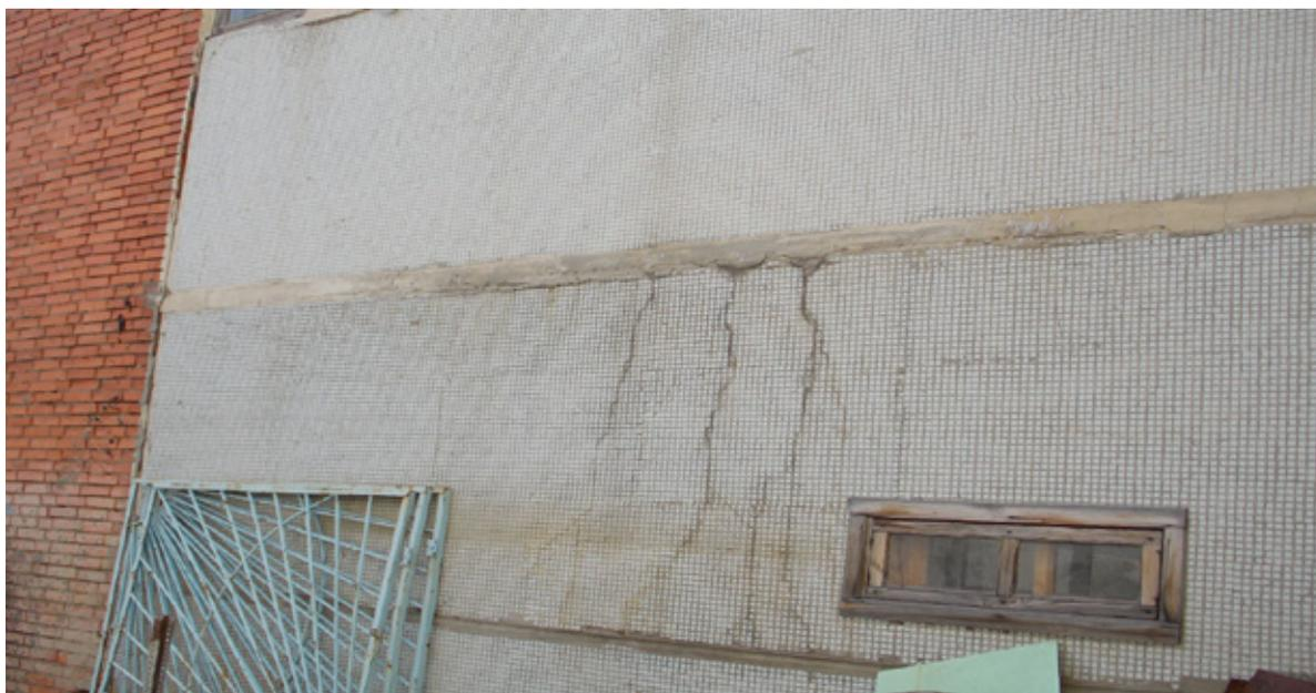
Рис. 1. Отдельные трещины и выбоины с шириной трещин менее 5 мм (Категория В)
