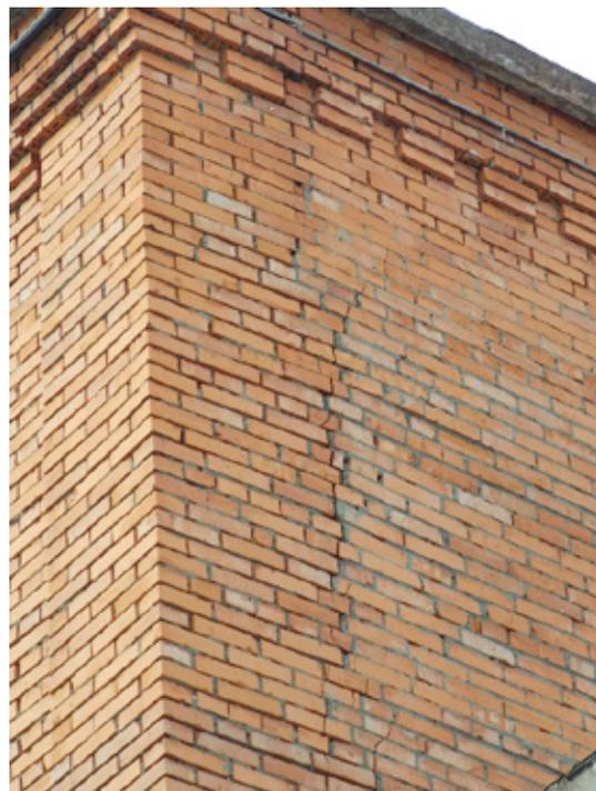
Рис. 1. Отдельные трещины и выбоины с шириной трещин пересекающие кладку более чем на 8 рядов (Кат. Б)
