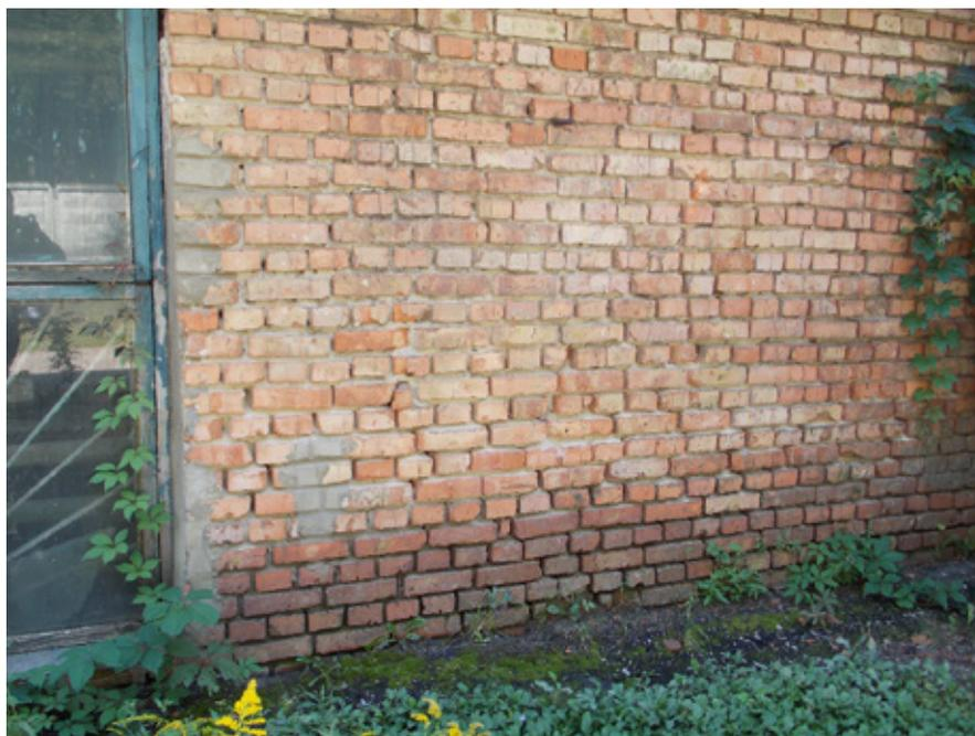
Рис. 2. Выветривание швов кирпичной кладки в цоколе (Кат В.)
