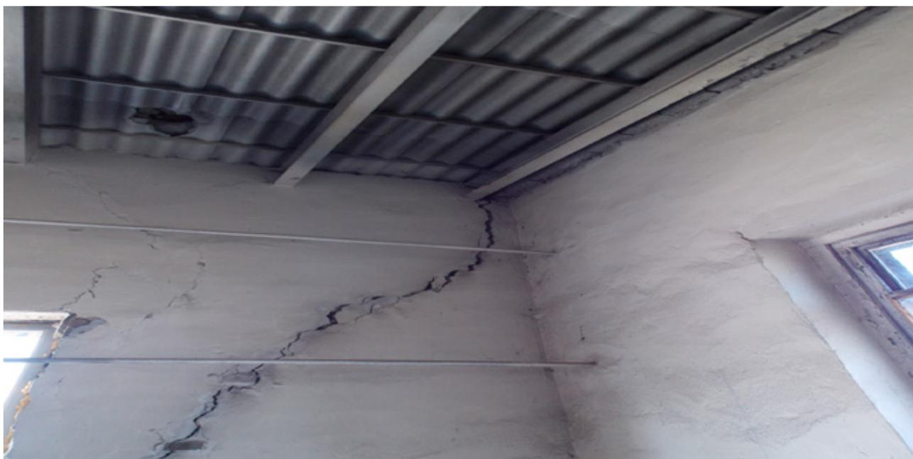
Рис. 1. Отдельные трещины и выбоины с шириной трещин более 5 мм (Категория Б)
