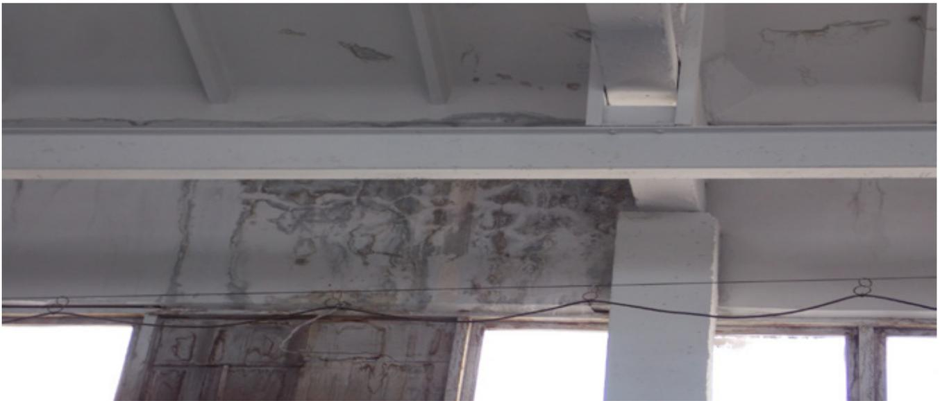
Рис. 3. Замачивание ограждающих конструкций (Категория В)
