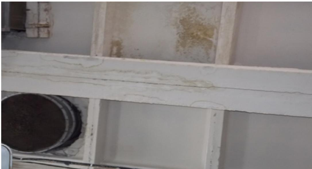
Рис. 3. Протечки в кровле (Кат. В)
