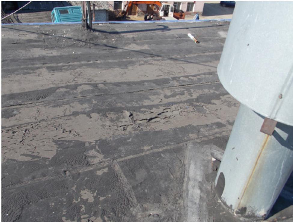
Рис. 4. Нарушение целостности кровельного покрытия (Категория В)
